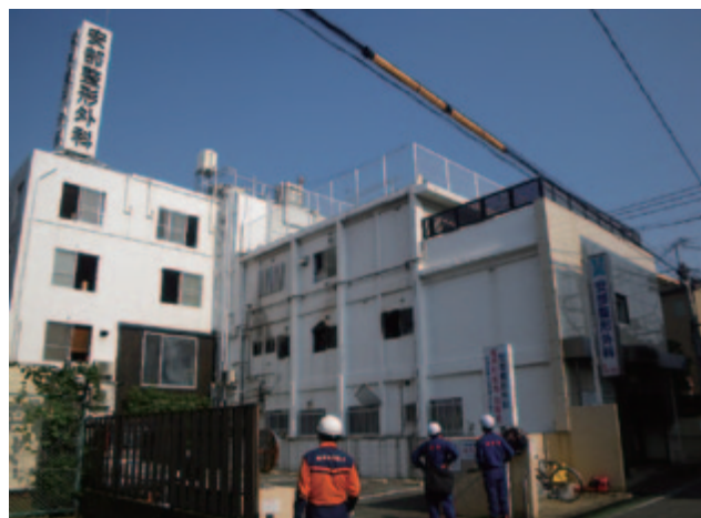
火災建物の外観
