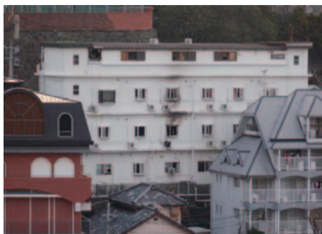
火災建物(中央白の建物)の外観
